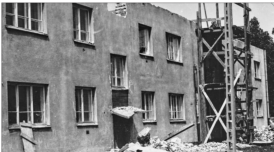
Nadbudowa przedwojennego budynku mieszkalnego
