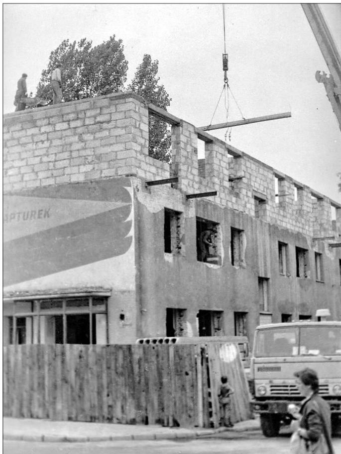
Nadbudowa bloku przy ulicy Sikorskiego 8 (zdj. z archiwum „Życia FLT”)
