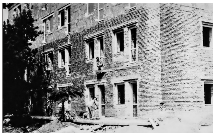
Prace murarskie w nadbudowanym bloku
