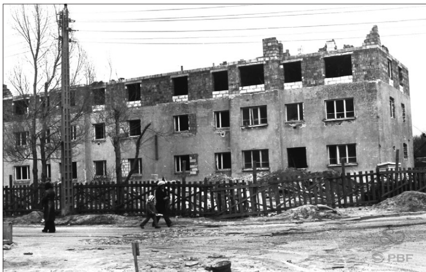
Nadbudowa bloku przy ul. Słowackiego 1, w tym budynku w czasie wojny znajdowała się komendantura Obozu Pracy w Budzynie
