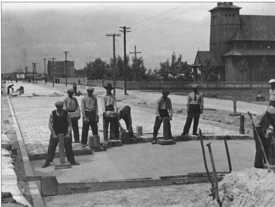
Roboty publiczne w 1939 r. finansowane przez Fundusz Pracy w Lublinie. Wyrównywanie piaskiem i układanie kostki, Archiwum Państwowe w Lublinie, Akta miasta Lublina, sygn. 4148
