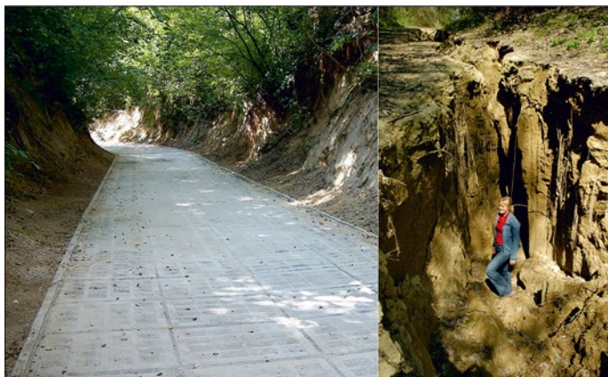
Utwardzenie dna wąwozu w Wierzbicy
