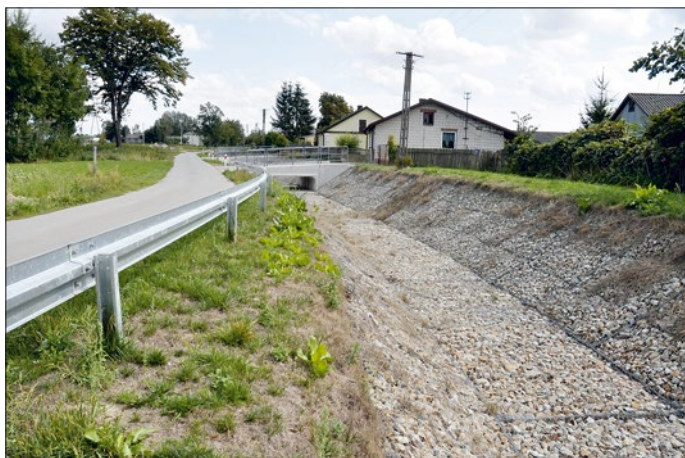
Zmodernizowany kanał Podlipie w Moniakach
