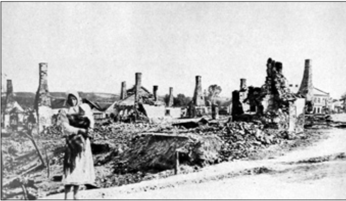
Spalone zabudowania Urzędowa – lipiec 1915 r.
