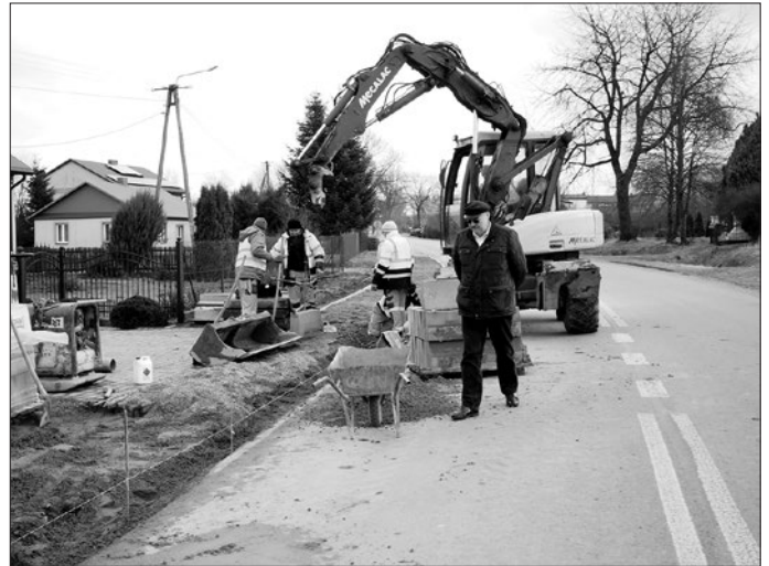
Budowa chodnika dla pieszych w Popkowicach
