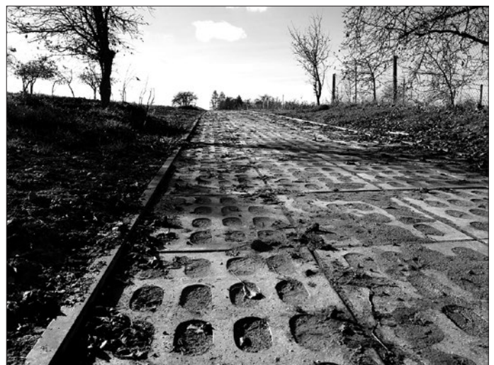
Wybudowana droga gminna w Urzędowie
