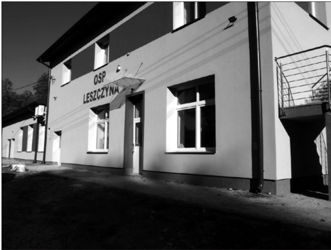
Przy odnowionej remizie OSP w Leszczynie planowane są jeszcze roboty wokół budynku strażnicy
