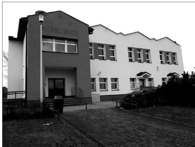
W ostatnim czasie odnowiono remizy OSP w Popkowie (na zdjęciu), Leszczynie i Wierzbicy
