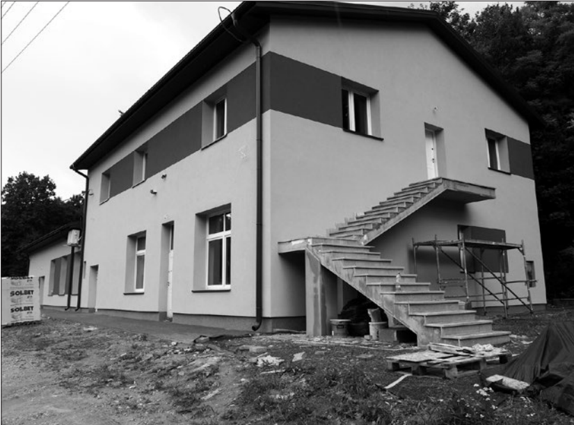
Budynek OSP w Leszczynie zaraz po przeprowadzonej w tym roku termomodernizacji
