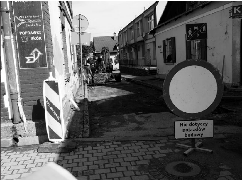
Remontowane uliczki w centrum Urzędowa
