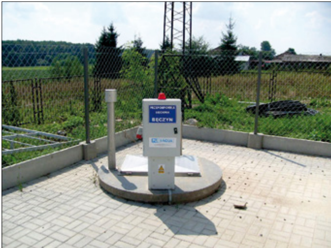
Przepompownia sieciowa Bęczyn
