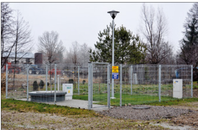
Przepompownia sieciowa Zakościelne
