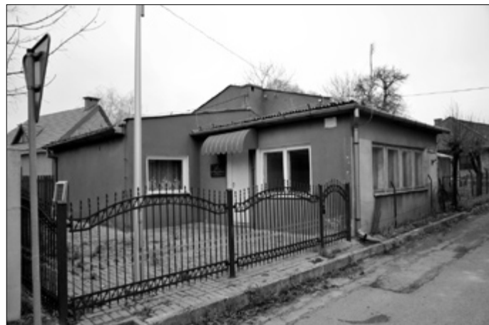
Budynek przy ul. Prof. Wośko dzisiaj (fot. L. Dudziński)
